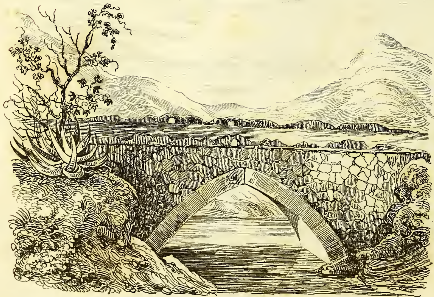
2. Pont Antique à Châlons.
